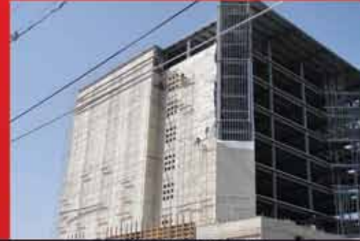
FORRO PRESIDENCIA MUNICIPAL TRC
