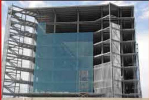
FORRO PRESIDENCIA MUNICIPAL TRC 2
