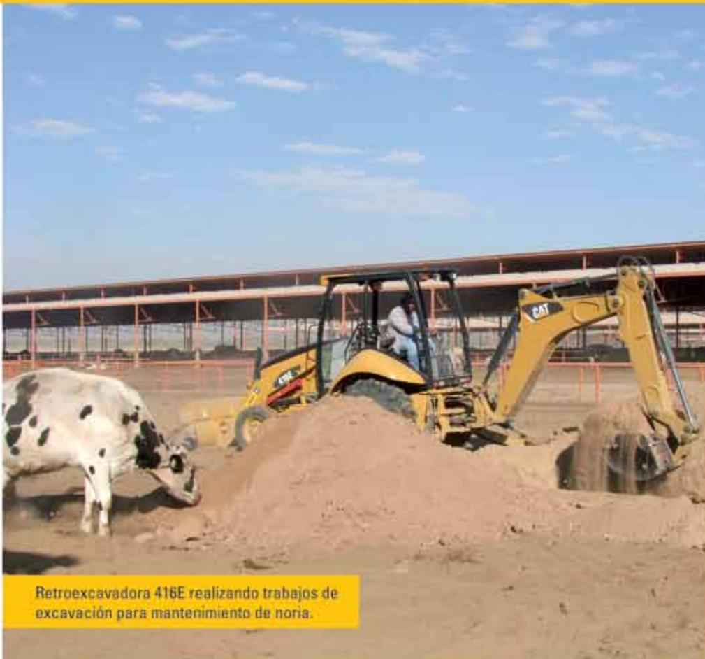
Retroexcavadora 416E realizando trabajos de excavación para mantenimiento de noria.
