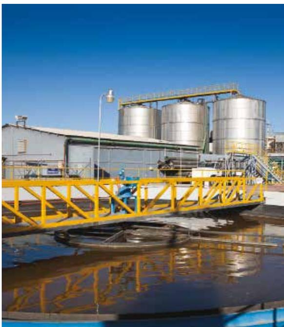
la laguna de oxidación, reducción de olores de la descomposición de materia orgánica y mejora en las condiciones de descarga de agua residual al Sistema Descentralizado de Agua Potable y Alcantarillado de Gómez Palacio, Dgo., contribuyendo al buen funcionamiento de la planta tratadora municipal.
