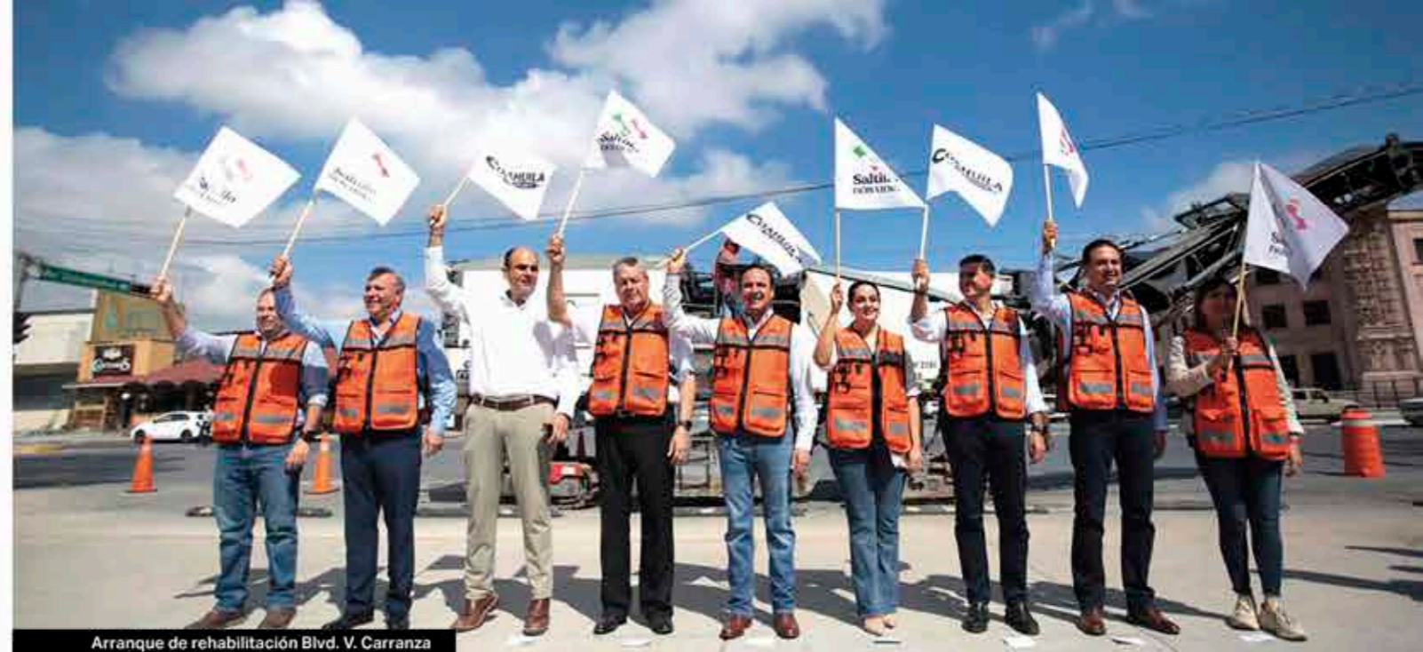
Arranque de rehabilitación Blvd. V. Carranza
