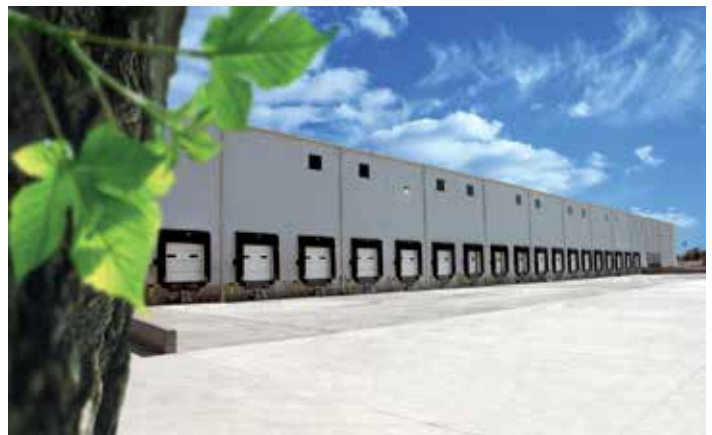
Centro de Distribución Sustentable en Guadalupe, NL.
