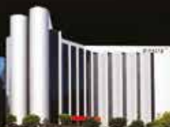
IZabc TORRE ALESTRA MONTERREY
