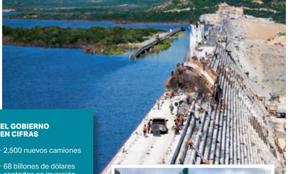
Construcción de la presa Libertad
