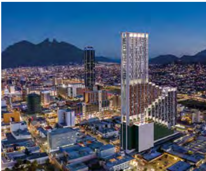
▲ Libertad HO Monterrey, Nuevo León
