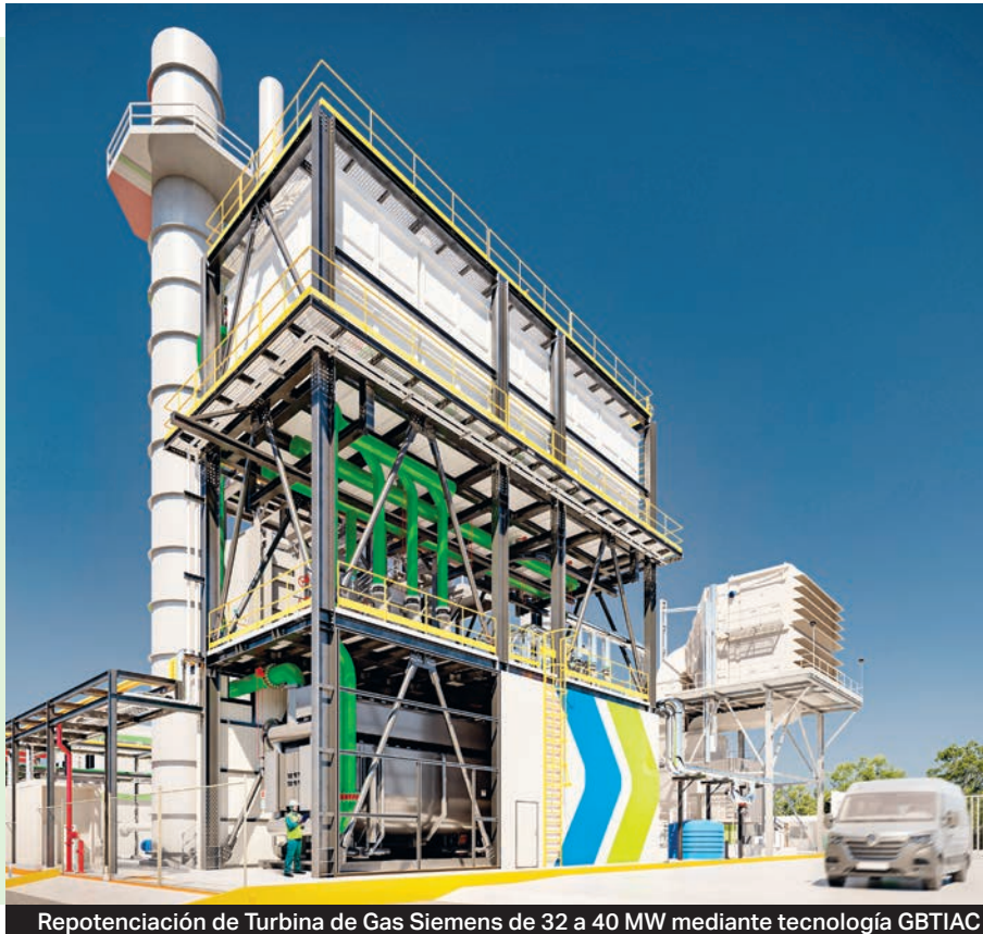
Repotenciación de Turbina de Gas Siemens de 32 a 40 MW mediante tecnología GBTIAC
