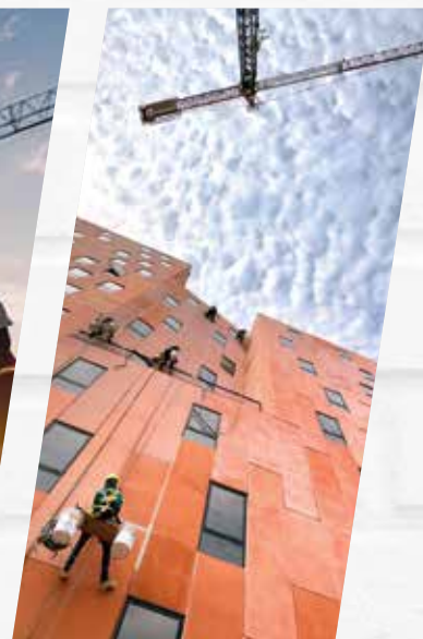
LIMPIEZA Y PINTURA
