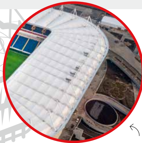
La cubierta está compuesta por 45 bloques de acero que sostienen una membrana de poliéster
